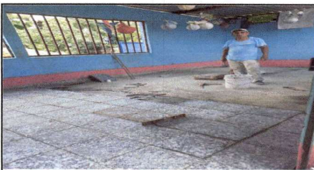
Foto 5: aula a la cual se le está colocando piso de granito.
