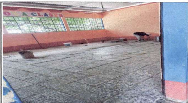
Foto 3: aula a la que se le está colocando piso de granito nuevo.
