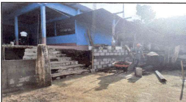
Foto 4: cernido, repello y sellado de grietas en muro.
