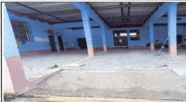
Foto 2: trabajos de colocación de piso de granito en corredor.
