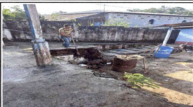
Foto 7: área donde se colocarán los balcones a los que se les dará mantenimiento
