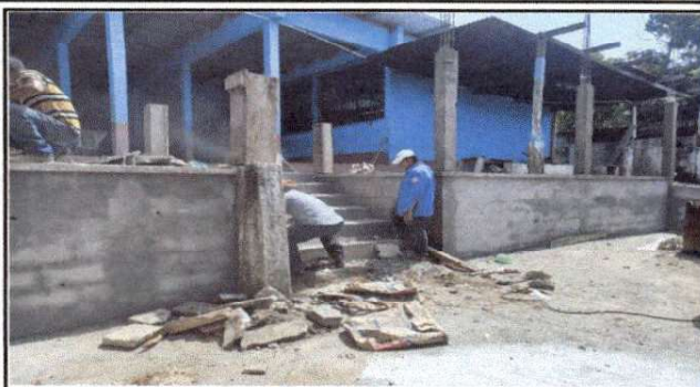
Foto 8: preparación de pilares para colocar los balcones de metal que se les dará mantenimiento.
