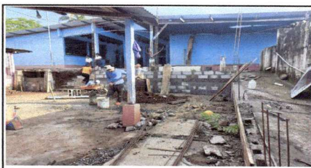
Foto 6: cernido, repello y sellado de grietas en muro.
