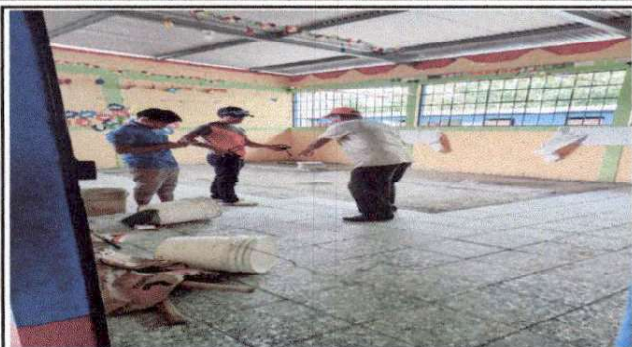
Foto1: colocación de piso de granito en aula.
